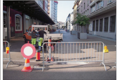
RUE DU MARCHÉ Le tronçon de rue devant la Poste est depuis hier inaccessible en voiture depuis la place du Marché. (LÉO BYSAETH)
